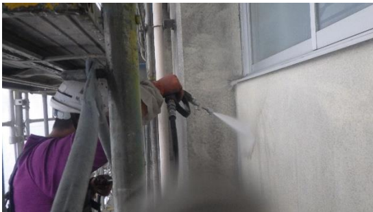
□校舎外壁改修工事
