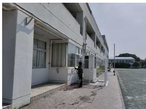
業者による窓ガラスの清掃。
