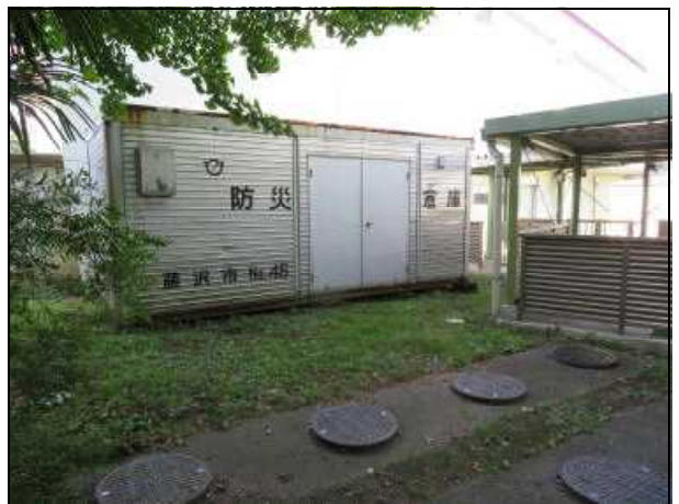
体育館前にある防災倉庫
